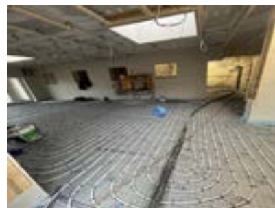
Her er gjort klart til gulvvarme i den nye garderobe. Væggen bagerst er den tidligere ydermur. Foto: Michael Vogel
