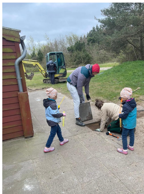
Minigraveren i baggrunden, som var lånt gratis, var en stor hjælp til noget af det mere grove arbejde, for eksempel et nyt fliseparti ved indgangen. Privatfoto
