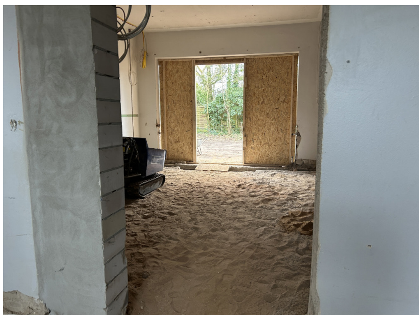
FØR: Ved hullet i muren skal den 17 kvadratmeter store vinterhave-tilbygning være. Til venstre anes den gravko, der har opholdt sig mange uger i Store Vi-Vanderup Danske Skoles underetage. Foto: Trine Flammig
